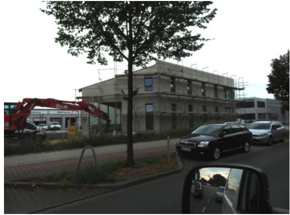
Fertigstellung Waschhalle und Versickerungsflächen
