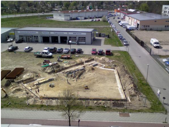
Gründung Neubau Waschhalle
