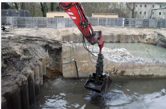
Bodenaustausch durch Trocken- und Nassaushub
