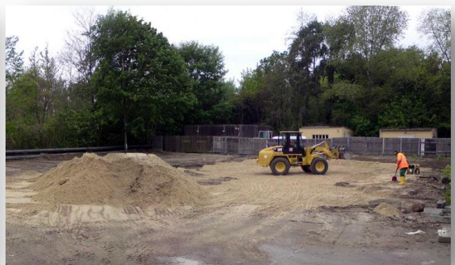
Tankstellenbereich nach Bodenaustausch
