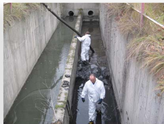
Gereinigter Absehraum bei der Abnahme
