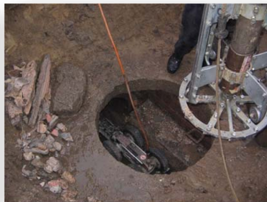
Kamerabefahrung nach dem Fräsen
