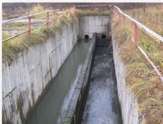
Reinigung des Absetzbeckens
